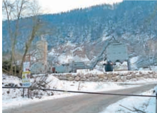
Peskokop Črna, kjer od oktobra deluje tudi mobilna asfaltna baza.
